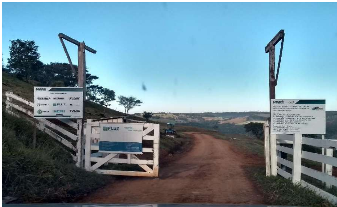
Figura 5 - Acesso a CGH Tapera 2A.
