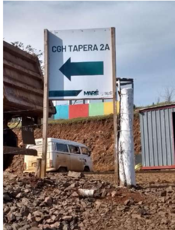
Figura 13 - Placa instalada na CGH Tapera 2A.
