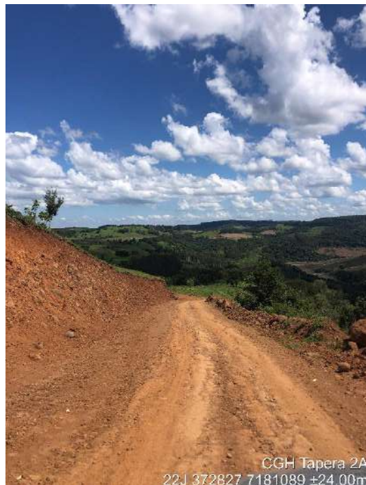
Figura 10 - Estrada de acesso a CGH Tapera 2A.
