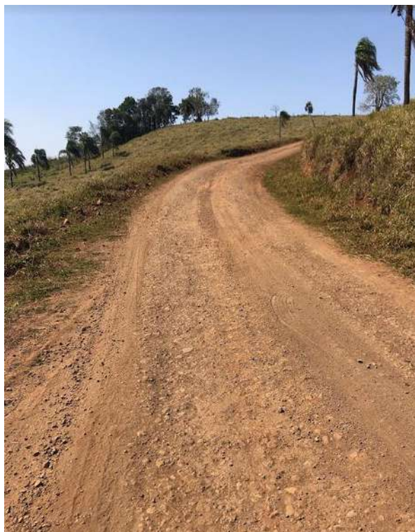
Figura 7 - Estrada de acesso a CGH Tapera 2A.
