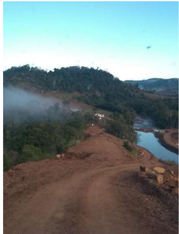
Figura 9 - Estrada de acesso a CGH Tapera 2A.
