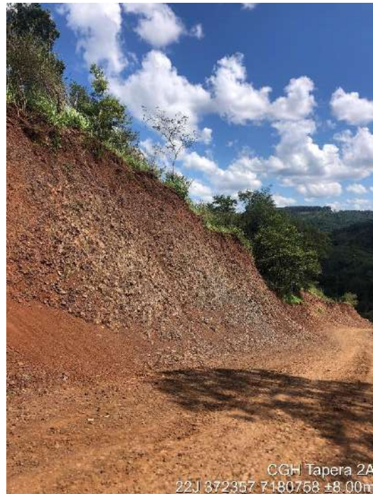
Figura 13 - Estrada de acesso a CGH Tapera 2A.
