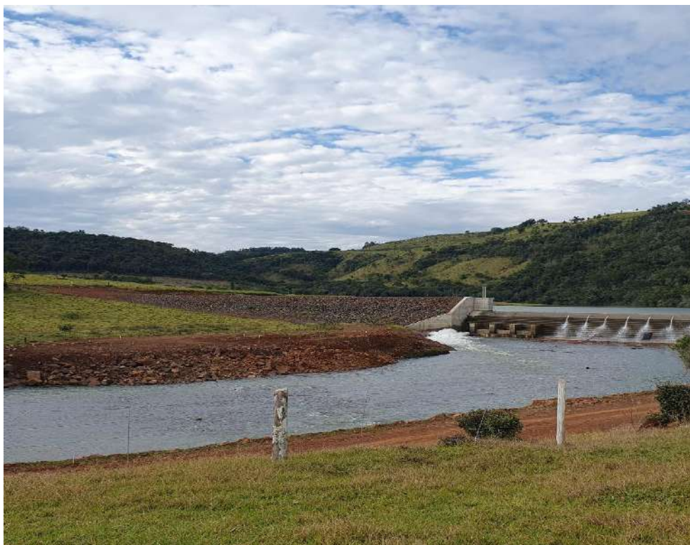
Figura 8 - Acesso interno CGH Tapera 2A.
