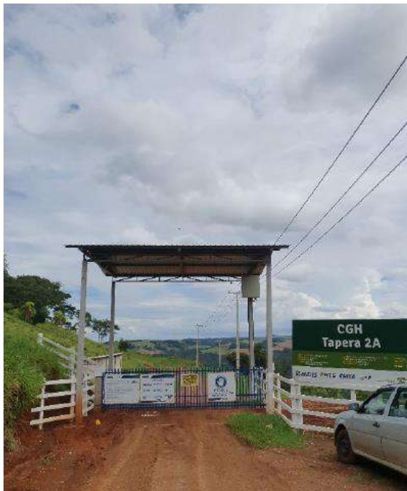
Figura 2 - Estrada de acesso a CGH Tapera 2A.
