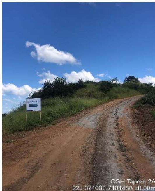
Figura 6 - Estrada de acesso a CGH Tapera 2A.
