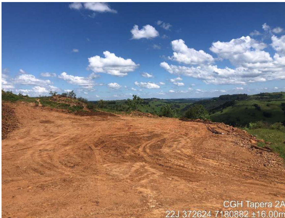
Figura 11 - Estrada de acesso a CGH Tapera 2A.
