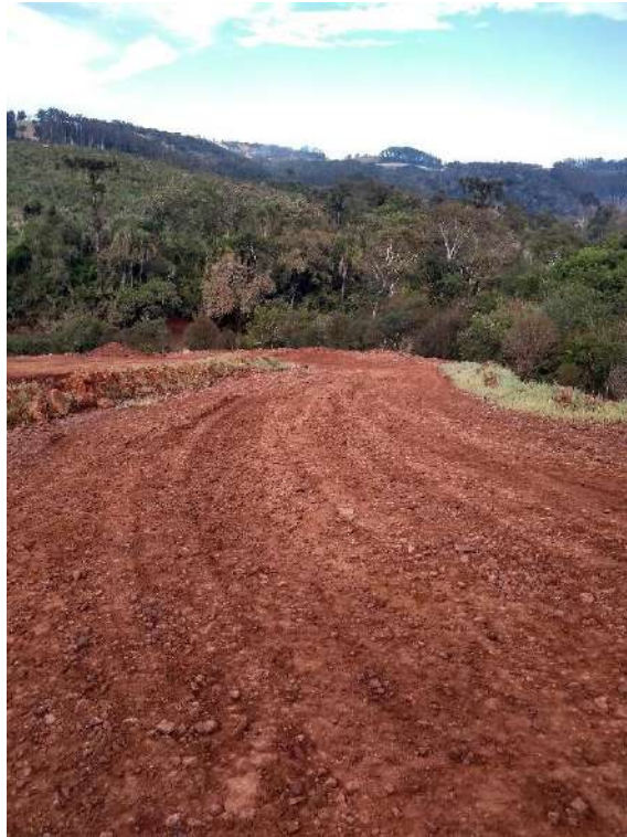
Figura 12 - Estrada de acesso a CGH Tapera 2A.
