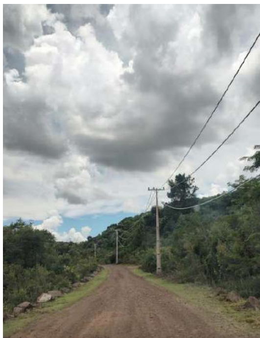
Figura 3 - Estrada de acesso a CGH Tapera 2A.
