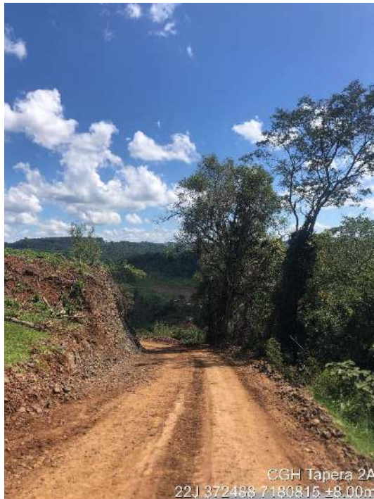
Figura 12 - Estrada de acesso a CGH Tapera 2A.
