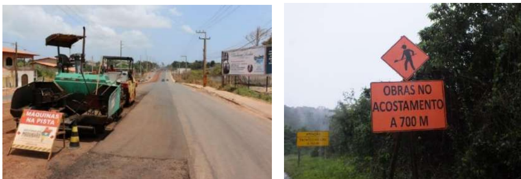
Figura 2 - Exemplos de sinalização para máquinas na pista.
