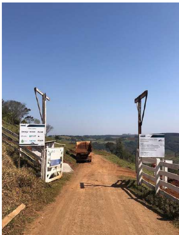
Figura 3 - Placas instaladas na CGH Tapera 2A.
