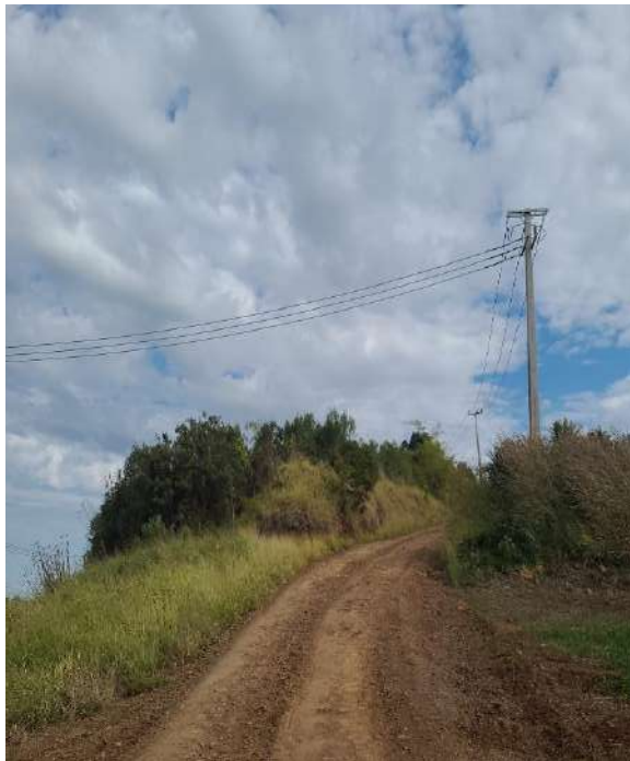
Figura 2 - Estrada de acesso a CGH Tapera 2A.
