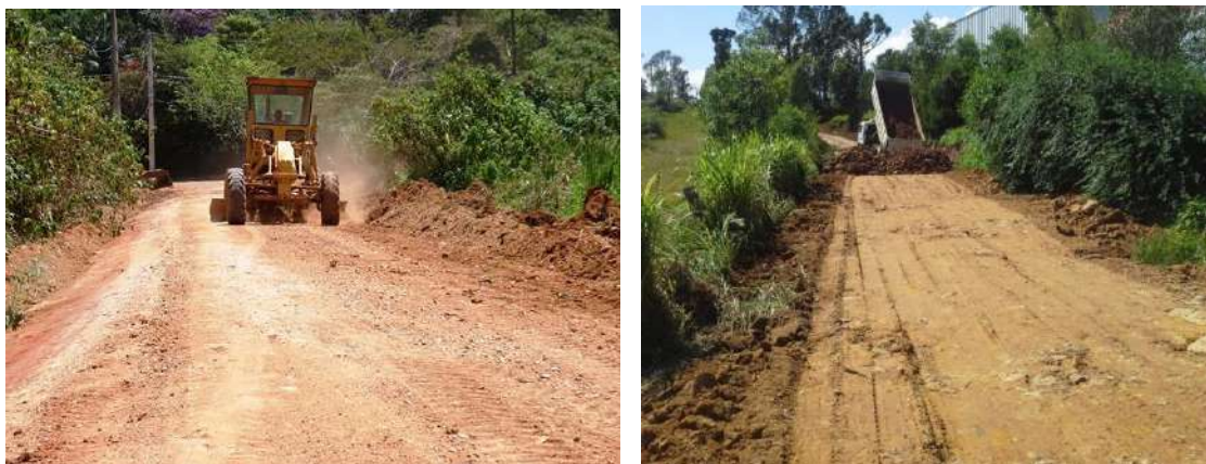
Figura 4 - Exemplos de obra de recuperação e melhoria de estradas.
