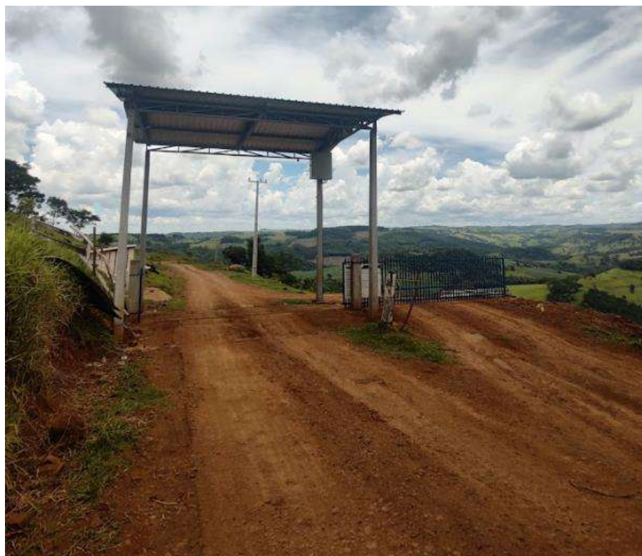
Figura 5 - Acesso à CGH Tapera 2A.
