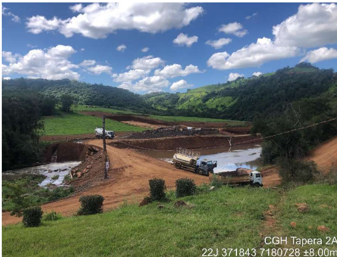
Figura 14 - Estrada de acesso a CGH Tapera 2A.
