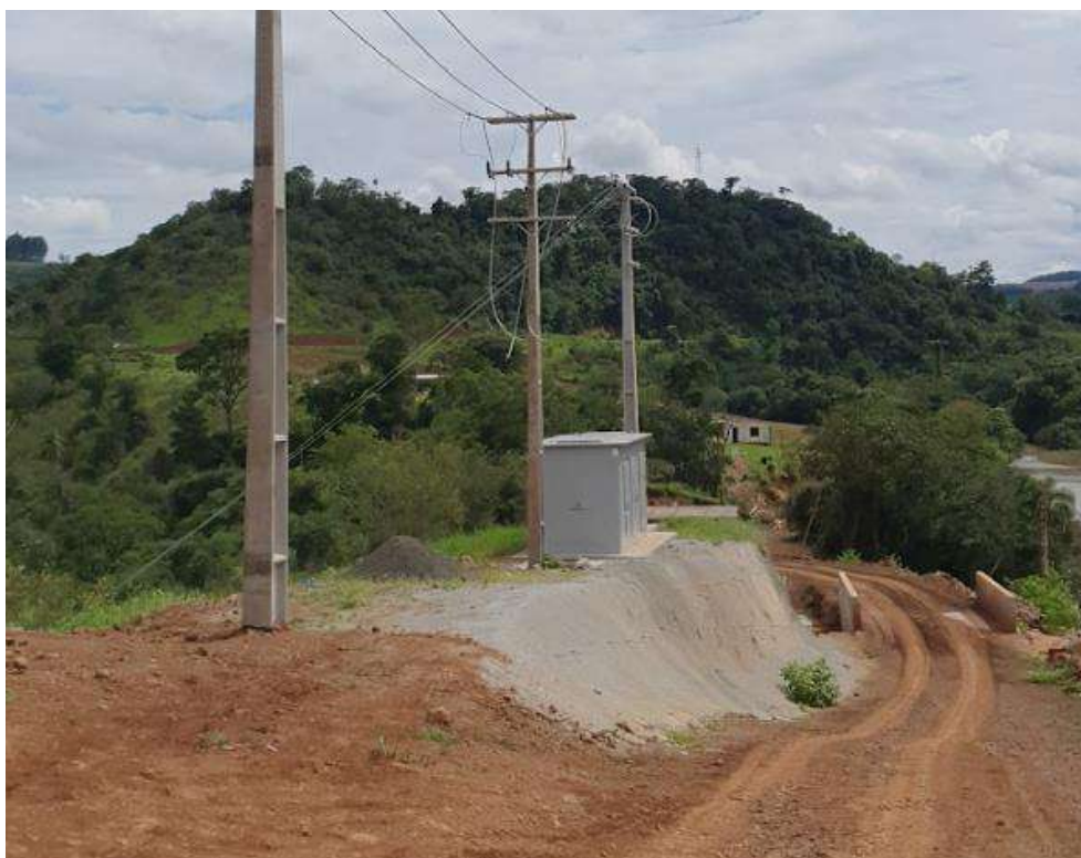
Figura 8 - Acesso interno CGH Tapera 2A.
