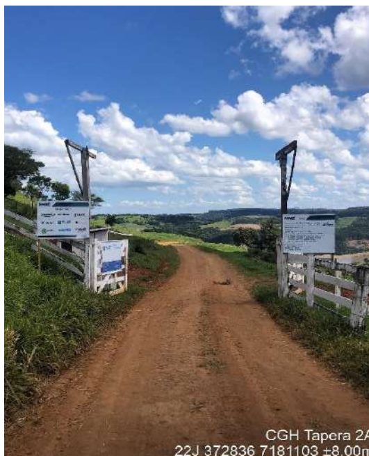
Figura 7 - Estrada de acesso a CGH Tapera 2A.
