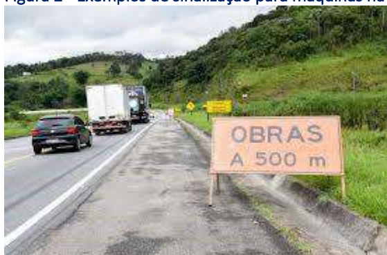
Figura 3 - Exemplos de sinalização de obras na pista e desvio.
