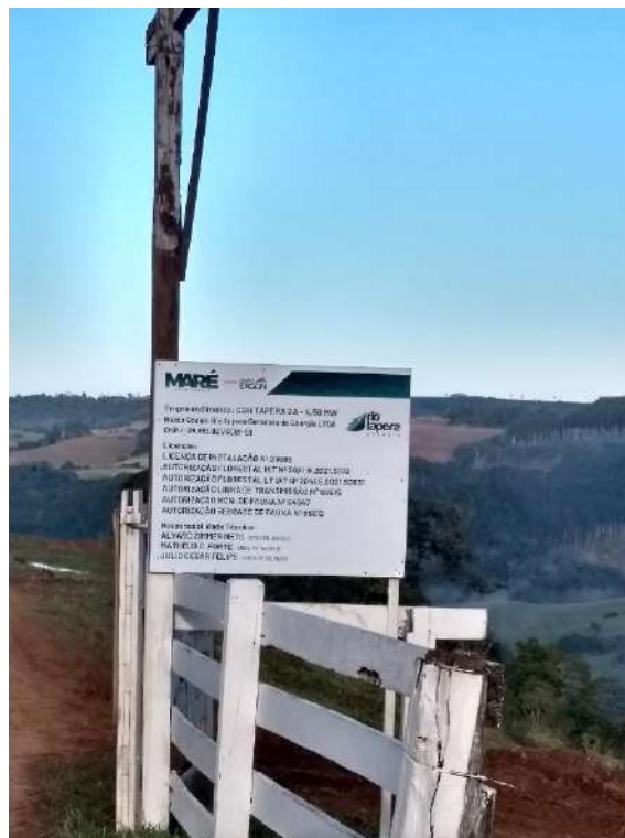
Figura 7 - Placa instalada na CGH Tapera 2A.
