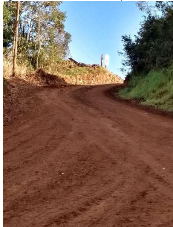
Figura 11 - Estrada de acesso a CGH Tapera 2A.
